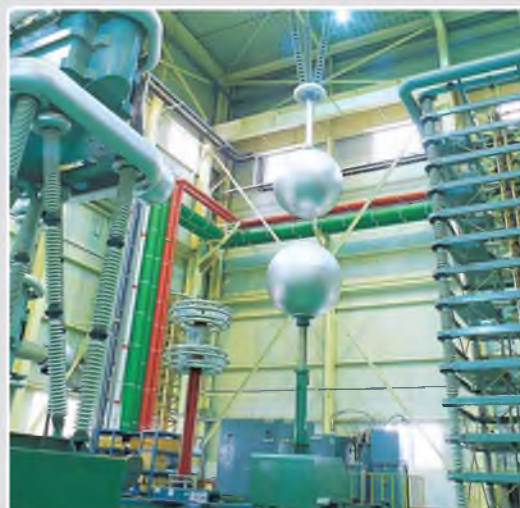
Высоковольтные испытания | Тест импульса
