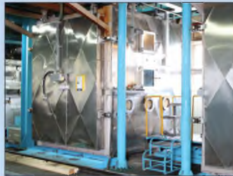
Вакуумная пропитка обмоток
